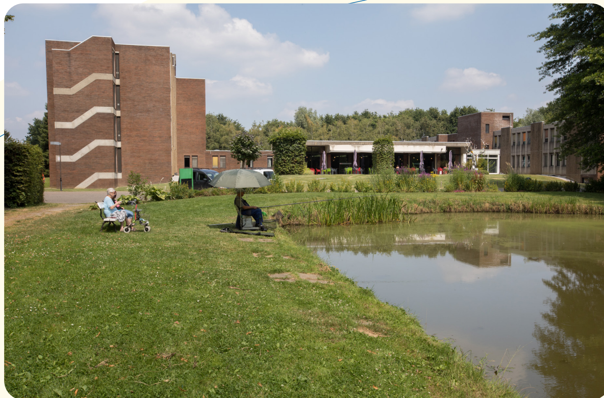
Waar nu de vijver is, wordt het nieuwe Huize Sint-Augustinus gebouwd.
